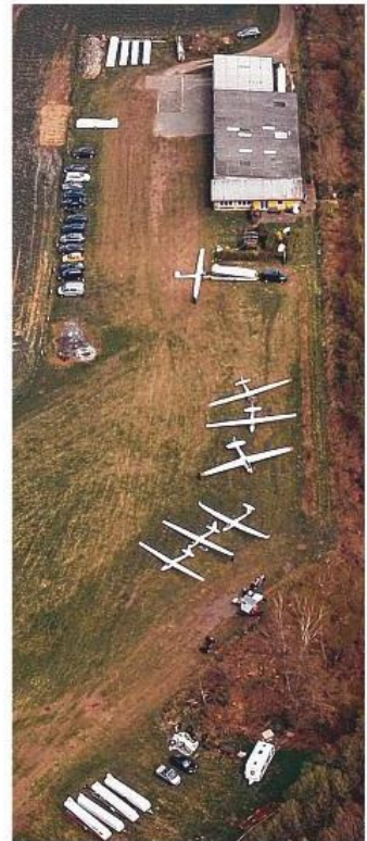
Das Vereinsgelände von oben: Das Dach der Flugzeughalle soll bis zum Herbst umfassend saniert werden.
