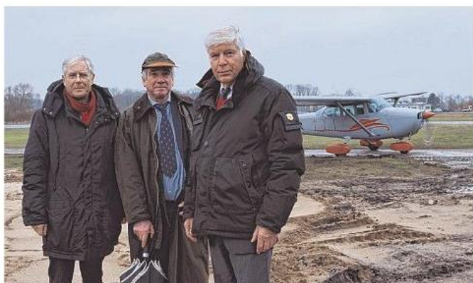
Am Rand der Rollbahn entsteht das neue Schulungszentrum des Luftsportverbandes Schleswig-Holstein: Martin Busch, Jörg Köpping und Wolfgang Müther, Präsident des Deutschen Aero Clubs (von links) auf der Baustelle.
